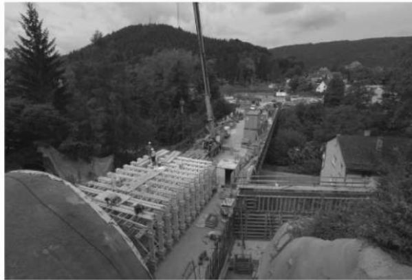
Montaż samojezdnego szalunku systemu NOETec w warunkach ograniczonego miejsca.
