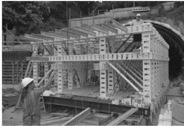
Montaż konstrukcji nośnej z dźwigarów systemu NOETec.
